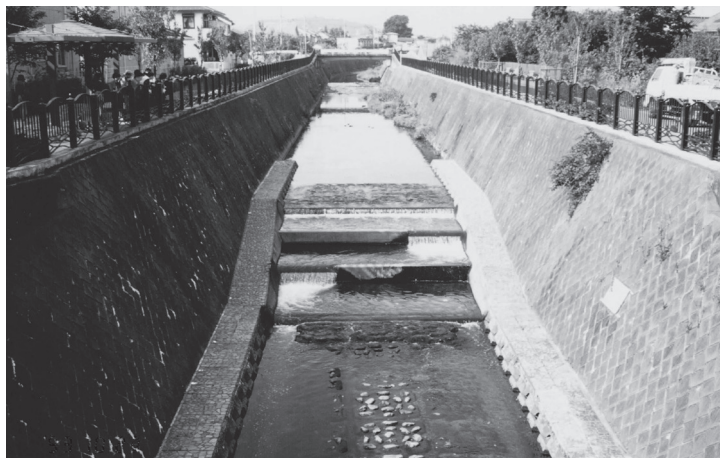
写真①-4 三面ともコンクリートでおおわれた都市の川 (撮影：大熊 孝)
