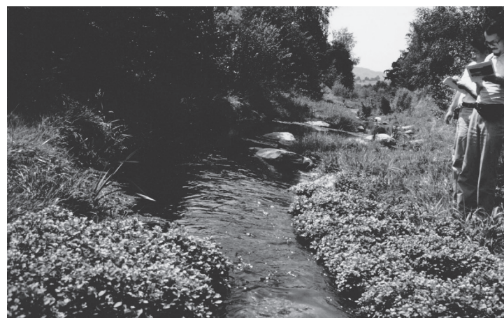
写真①-6 上のネフ川が近自然河川工法によって改修されたようす (撮影:大熊孝) 右手に立っている人たちは、わたしといっしょに視察に行った新潟の水辺を考える会の仲間
