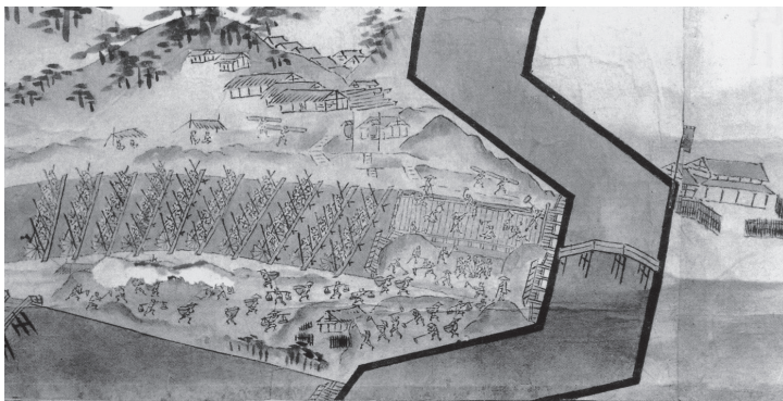
図①-2 新川底樋伏せ替え工事図
