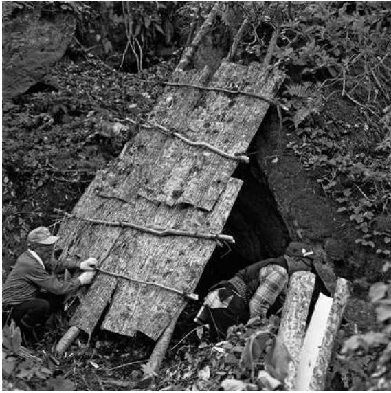
④ヤシの皮で屋根を葺く。皮は2段重ね。岩屋やヤシの木がどこにあるか、マタギは知っていた。
