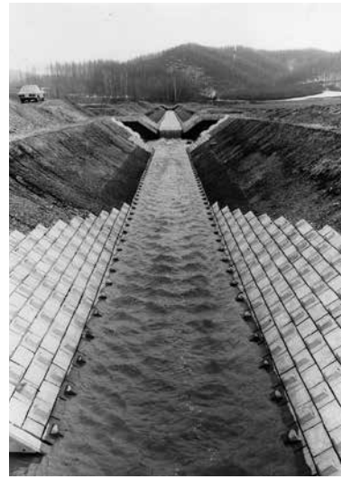
写真2 昭和50年代の土地改良事業によって直線化され、コンクリート護岸三面張りになり、落差工が設けられた駒生川。農家を悩ませた水害は減り、農業の生産性は高まったが生き物の姿は消えた（『駒生開基八十周年 駒生地区土地改良完工 駒生の歩み』から、駒生川に魚道をつくる会提供）
