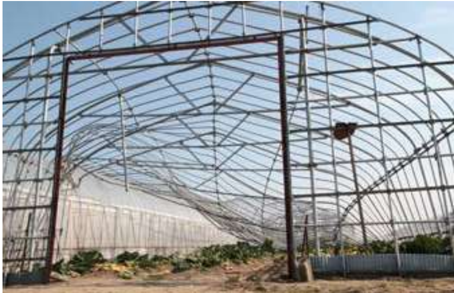
写真4-1 春の爆弾低気圧でパイプがひしゃげたハウス（編）
