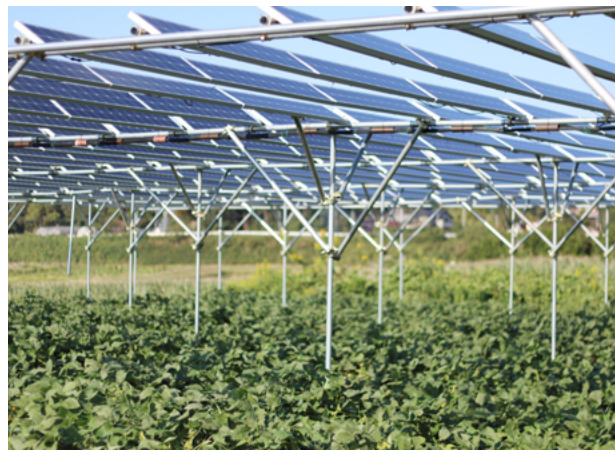
写真1 畑の上に設置したソーラーシェアリングのパネル。写真は市民エネルギーちばのグループ会社「Three Little Birdsの畑」。ダイズとコムギを有機で栽培している
